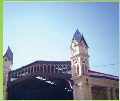
Estación Central del ferrocarril
